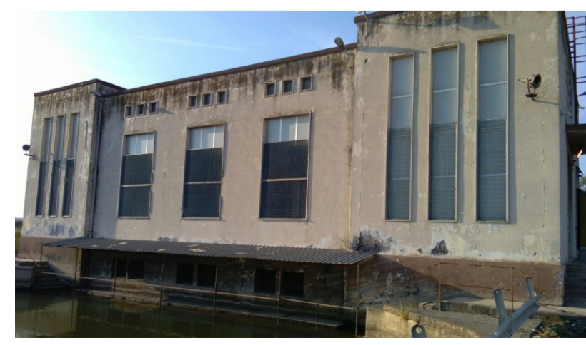
foto 3 immagine laterale Edificio Comandi dell'impianto idrovoro Gelsari
