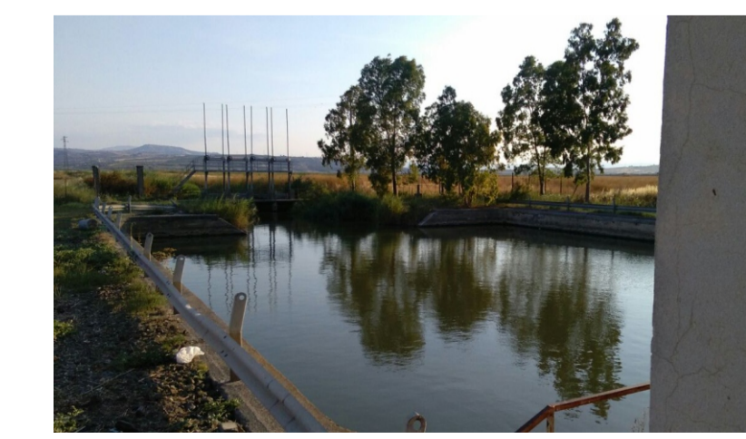
foto 4 immagine vasca di recapito dell'impianto idrovoro Gelsari
