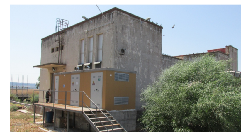
foto 2 immagine angolare Edificio Comandi dell'impianto idrovoro Gelsari
