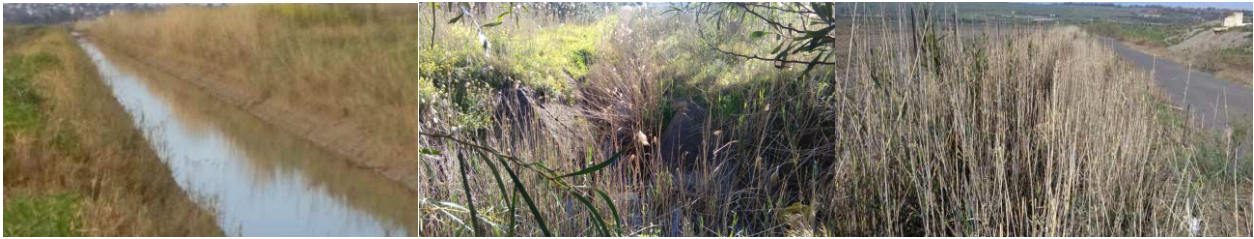
Fig. 6_FOTO CANALE ACQUE BASSE SUD
