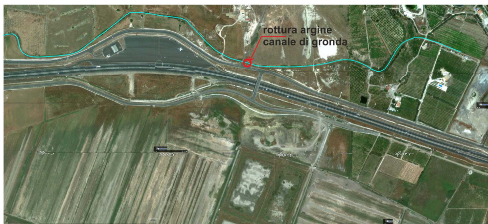
Figura 4 : foto indicante il punto del canale di gronda scalzato dalla furia della piena
