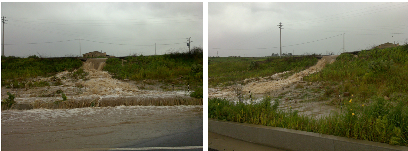
Figure 5 e 6 : Immagini dell'evento meteorologico in data 07-08/03/2012. Rottura del canale di gronda
