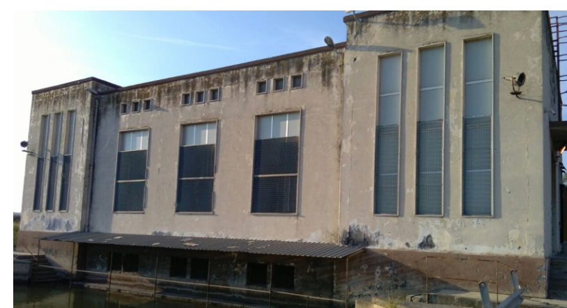
foto 3 immagine laterale Edificio Comandi dell'impianto idrovoro Gelsari
