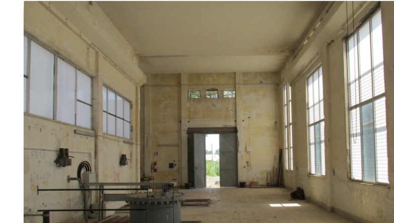
foto 7 immagine interna dell'impianto idrovoro Gelsari
