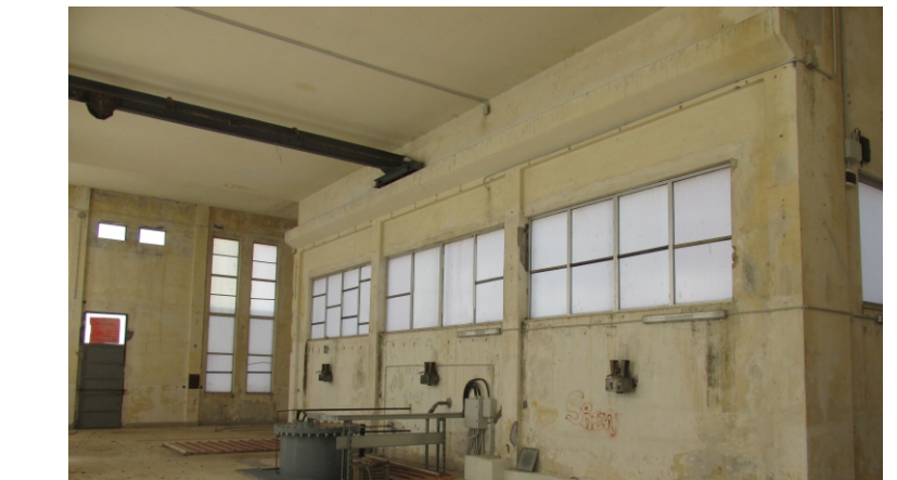
foto 8 immagine interna dell'impianto idrovoro Gelsari
