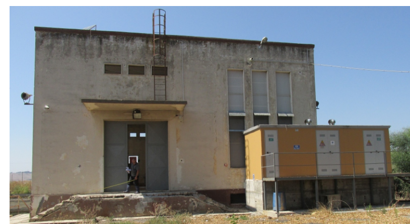
foto 1 immagine frontale Edificio Comandi dell'impianto idrovoro Gelsari
