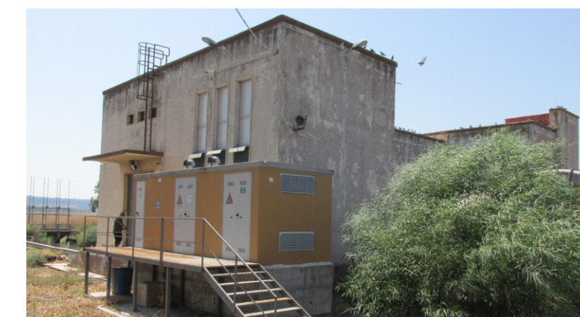
foto 2 immagine angolare Edificio Comandi dell'impianto idrovoro Gelsari
